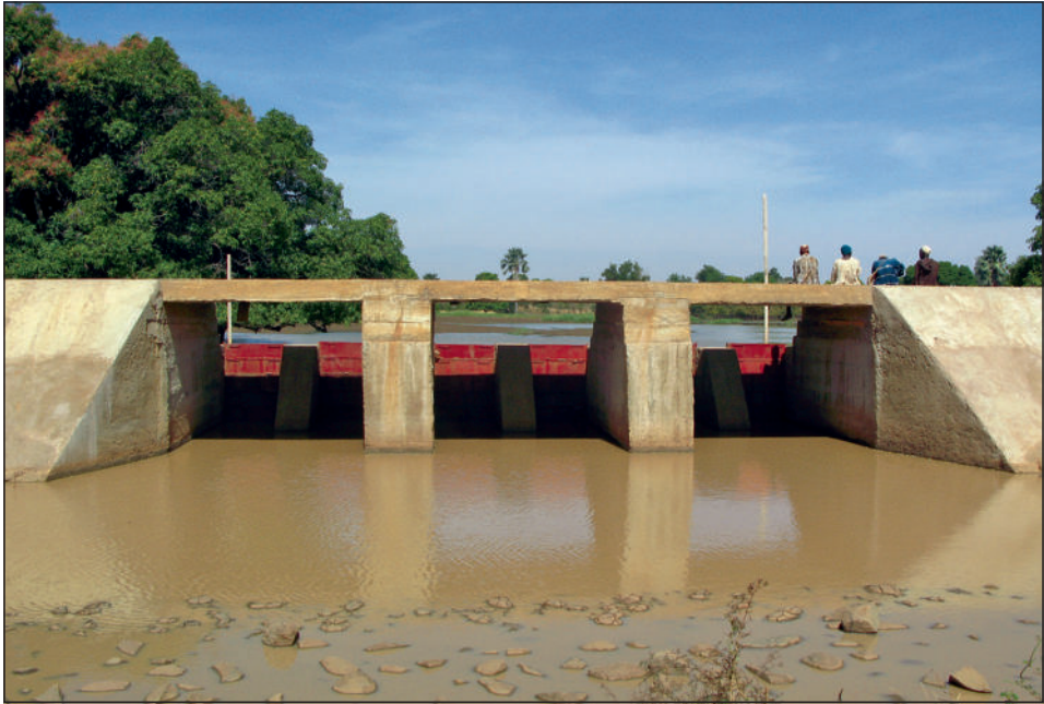
Abb. 4: Wasserrückhaltedamm in Mali (Foto: S. Krall, 2011)
